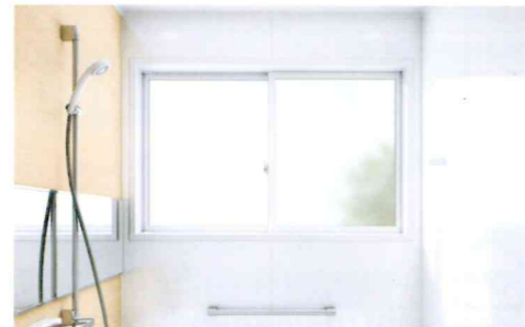
外窓交換：マドリモ 断熱窓
